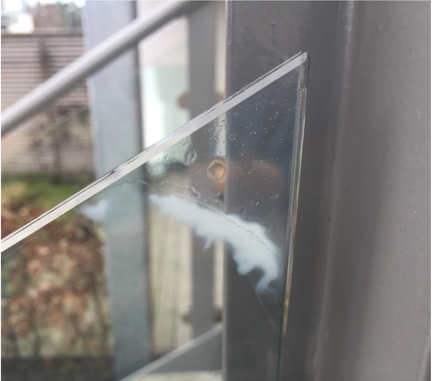
Bilde 1: Eksempel på delaminering typisk for kritiske formater.
