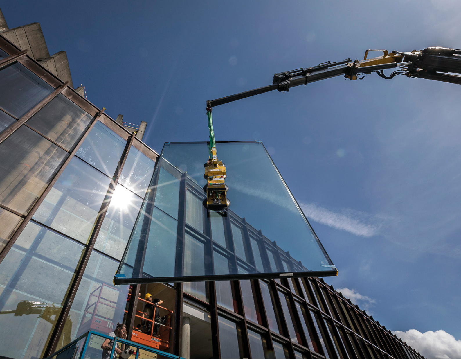
Løfteoperasjon på byggeplass.
